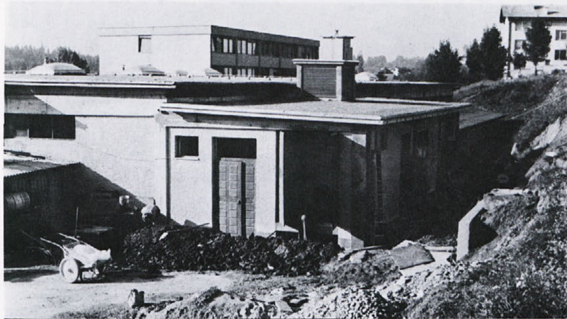
Nova transformatorska postaja v Novem mestu bo končno rešila zadnje čase že vse bolj pereč problem z oskrbo energije v TOZD Ločna. Na sliki transformatorska postaja in končna dela okoli njene usposobitve. (Foto: arhiv Labod)
