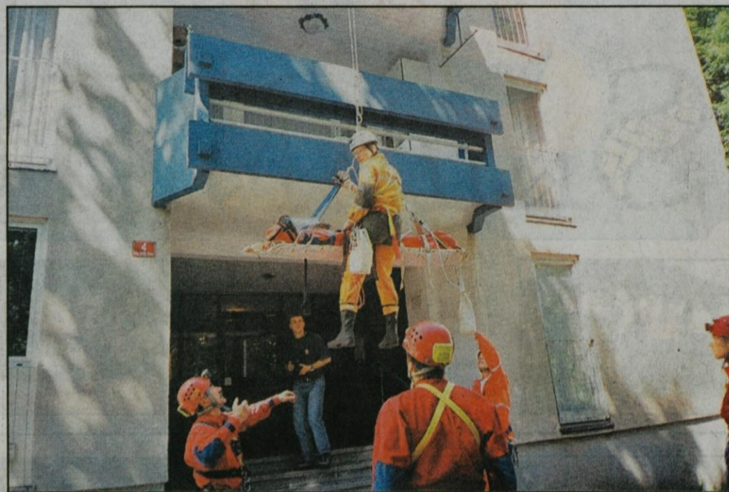
V Domžalah se je porušil del stanovanjskega bloka v Ulici Matije Tomca in v 11. nadstropju sta v stanovanju ostala ujeta dva občana, katera se zaradi porušenega objekta in poškodb nista mogla umakniti na varno. Rešila ju je Jamarska reševalna enota.
