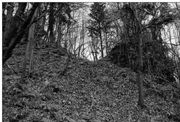
Obodno obzidje srednjega (levo) in spodnjega platoja grajskega kompleksa (desno). Pogled iz vzhodne strani, iz območja zunanjega grajskega obrambnega jarka pred nekdanjim glavnim grajskim portalom (foto: Igor Sapač, 2015).
