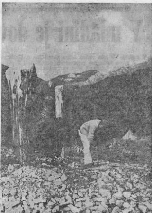
Dela pri gradnji žičnice na Mozirskih planinah hitro napredujejo. Prejšnji teden je prišla na gradbišče večja skupina delavcev, ki so pričeli z montažo tovrstne žičnice. Če bo šlo vse po sreči in ne pride kaj posebnega vmes, bo tovorna žičnica na Golte gotova že koncem meseca marca. (Foto: Berni)
