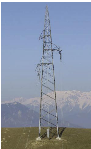
Slika 10 • DV 220 kV Kleče–Divača in 220 kV stebri na DV 110 kV Cerkno–Idrija
