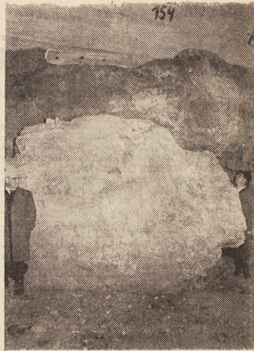
Ein gewaltiger Felsbrocken, der während der 14jährigen Arbeitspause im Tunnel aus den offenen Felschultern ausgebrochen ist
