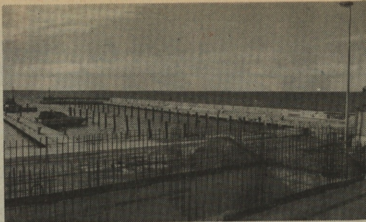
Po dograditvi valobrana, gradi zdaj Gradis Koper v koprski marini – GE Koper, Hidro Koper in Gradis Koper. Medtem ko so gradisovci delali dobesedno v in na morju, so ostali izvajalci gradili na kopnem.
