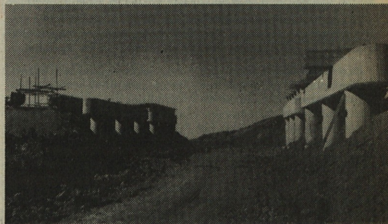
Isti objekt (3-01) slikan s spodnje strani. Pod avtocesto bo šel krak de-teljice, po katerem se bodo vozniki vključevali na avtocesto z ajdovske strani. Potrebno trdnost podporam nosilcev bo dajalo 24 pilotiranih Be-noto stebrov s premerom 1,5 metra.
