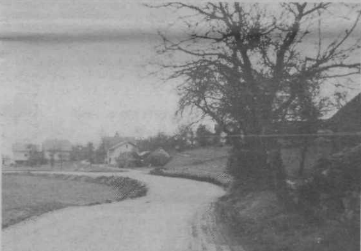
Dela na odseku ceste Plešivica—Lobčec potekajo po načrtu
