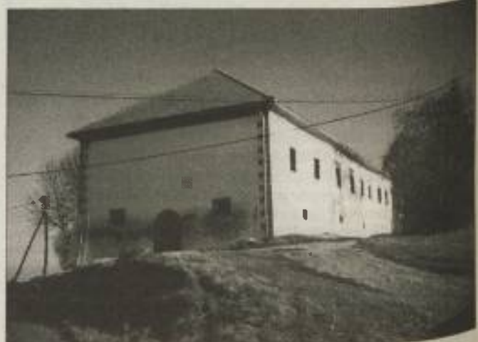
Pogled na znamenito zidnico »Hlaptov zid«, v Železnih dverih
