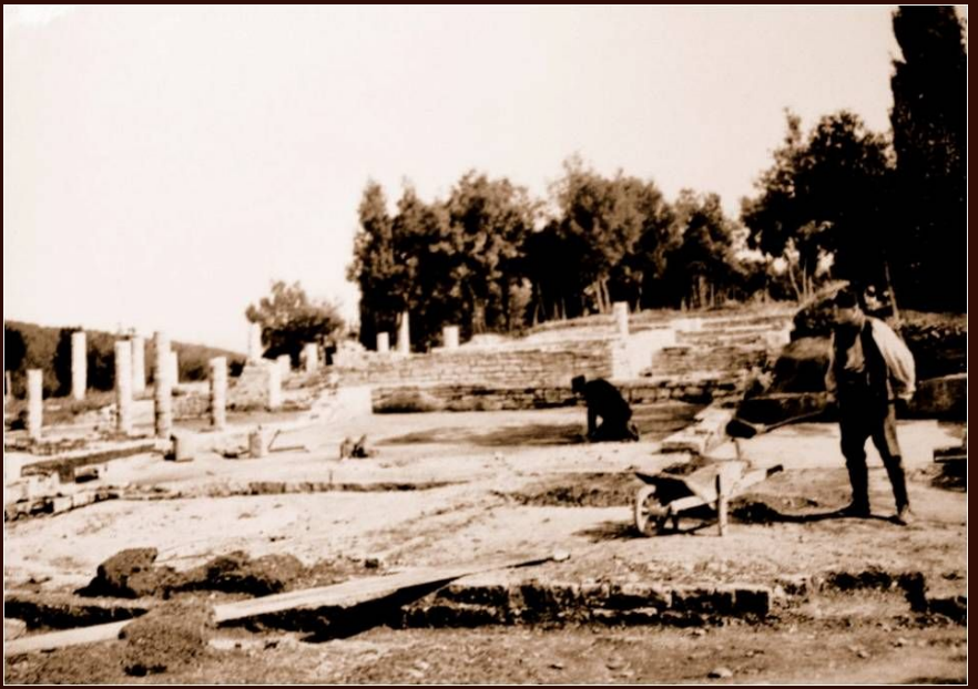
Lavori di scavo a Brioni sotto la direzione di Anton Gnirs in funzione di conservatore della Commissione centrale
