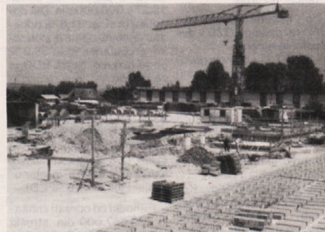
Delavci TOZD GO Celje opravljajo temeljenja nove stolpne betonarne v Medlogu. Foto: Darko Krušič
