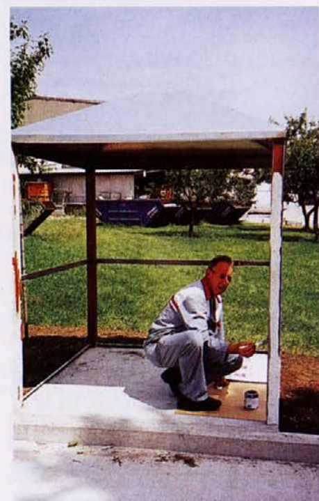
Pod nadstreškom bodo stali sodi z odpadnimi olji
