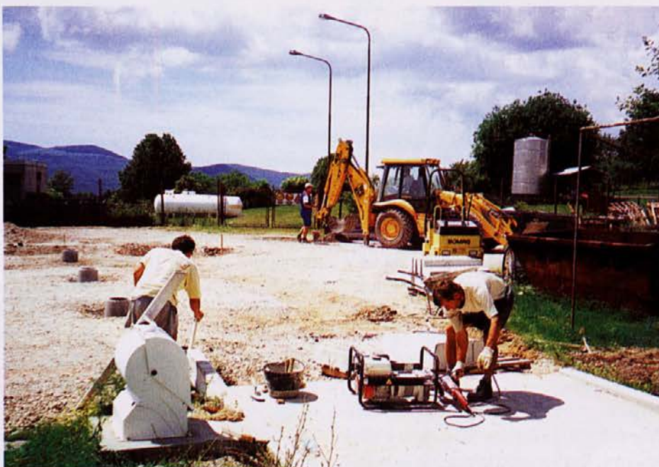
Tukaj gradimo ploščad za zabojnike z odpadki
