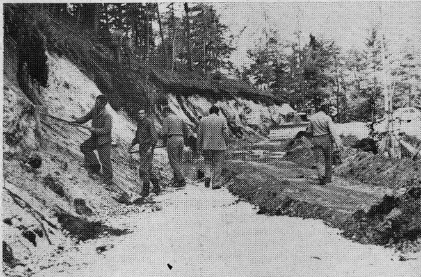
Gradbena in očiščevalna dela na cesti so bila precejšnjega obsega
