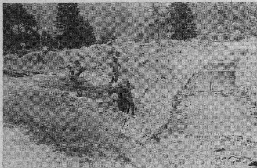
Urejanje hudournika v Logarski dolini. Dela potekajo pod težkimi pogoji, saj izvajalcem zelo nagaja talna voda in struktura tal
