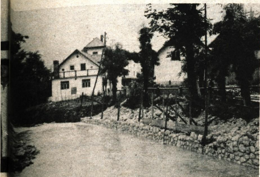
Škofja Loka Bistrica — Poleg lepo urejenega muzeja Tomača Godca v Bistrici nameravajo postaviti za obiskovalce še klopi in tudi sicer še urediti okolico. Zdaj so morali ob potoku, ki teče mimo muzeja, primerno postaviti obrežje in so zgradili oporne zidove. — Foto: Pauli Mencinger
