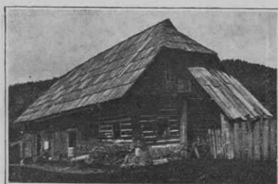
1. Zg. Borovlje, Koroška.
