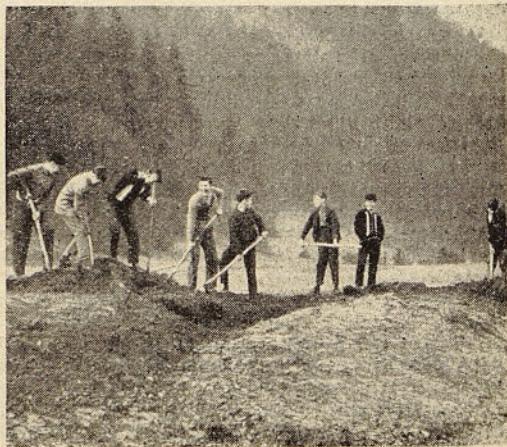
Okrog 80 gojencev Industrijske kovinarske žele »ISKRA« se je konec oktobra odzvalo prošnjemu terenskemu odboru SZDL Gorenja Sava in Vodovodna skupnost. Prišli so in s prostovoljnimi delom zasuli blizu 300 metrov kanala, ki so ga delavci izkopali in vanj položili cevi za vodovod
