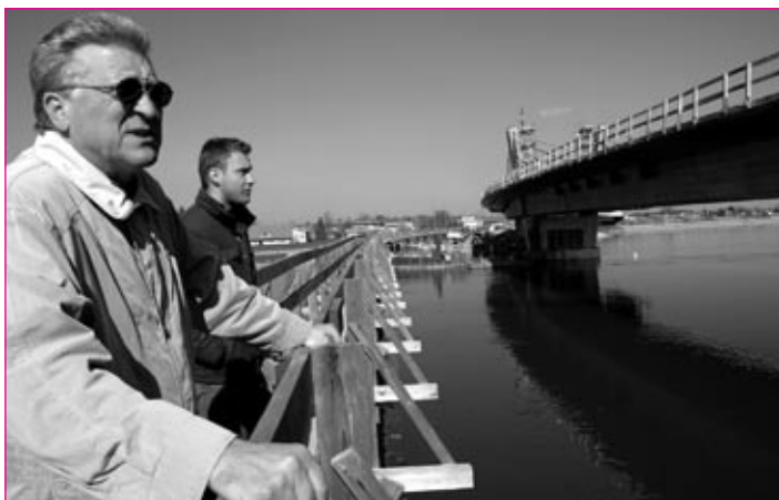
Puhov most bo končan predvidoma že 18. maja letos. Poimenovan je po izumitelju Janezu Puhu, predstavljal bo prvi tako imenovan ekstradosed most v Sloveniji. Na sliki: Jože Klenovšek, nadzorni inženir, in Marko Movrin.
