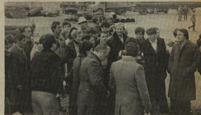
Celjani na gradbišču 60.000 tonskega silosa v Luko Koper
