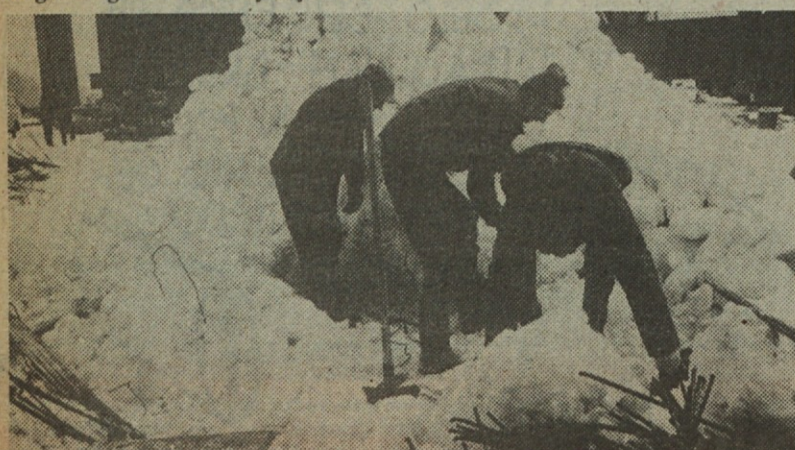
Po vsakem sneženju je treba armaturo odkopati izpod snega
