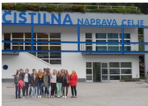
Slika 5: Z ogledom Centralne Čistilne naprave Celje dijake seznanimo s postopki čiščenja odpadnih voda.
