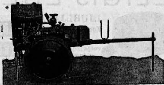
Lahka, dvokolna motorna brizgalnica z 16/18 HP motorjem, dobava vode 800 l v minuti, pritisk do 12 atm.
