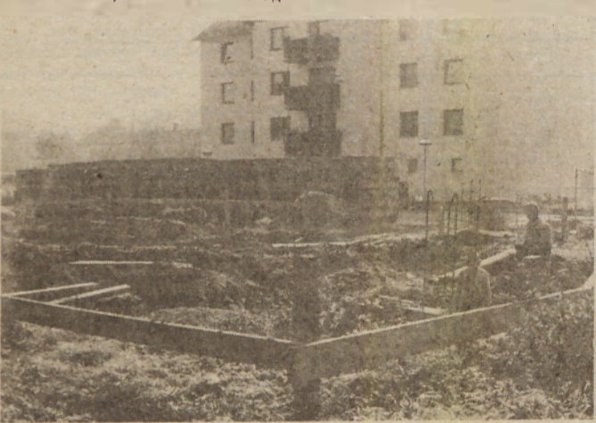
Gradnja novega stanovanjskega bloka v Beltincih.
