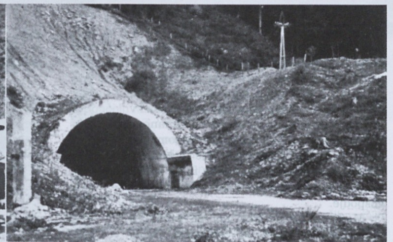
Še nedokončani predor Ljubelj
