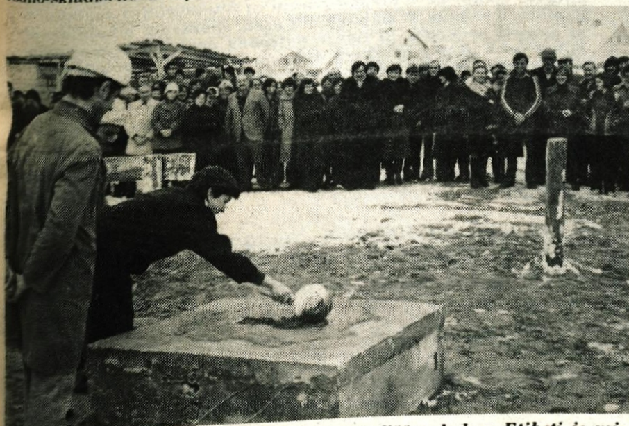
Temeljni kamen za novo proizvodno-skladiščno halo v Etiketi je vzdala Olga Strlič, ki je članica kolektiva že od ustanovitve in sicer od l. 9. 1959. leta. — Foto: J. Zaplotnik
