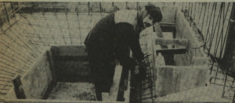
Gradbeniki moramo delati v težkih in dostikrat zdravju škodljivih delovnih pogojih. Na sliki: železokrivec polaga armaturo v času ko je zunaj snežilo in je bila temperatura pod ničlo
