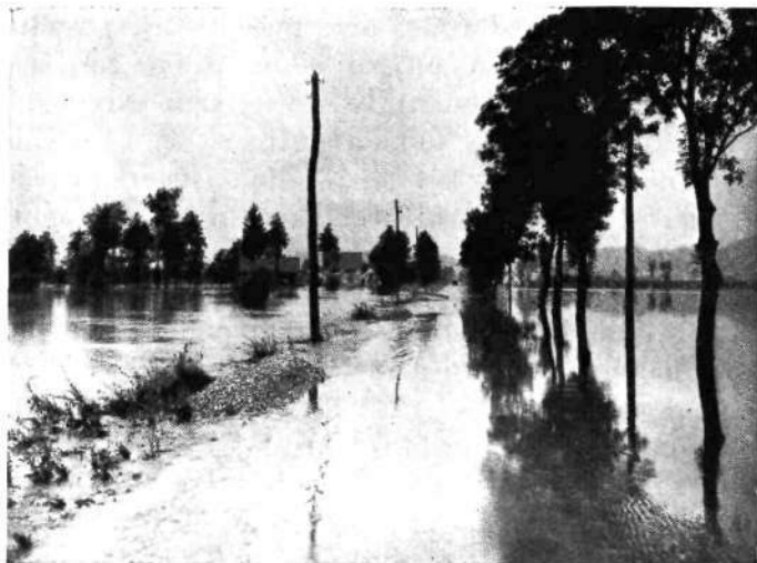
S poplavljenega Barja; pogled na Ižansko cesto v smeri proti Ljubljani
