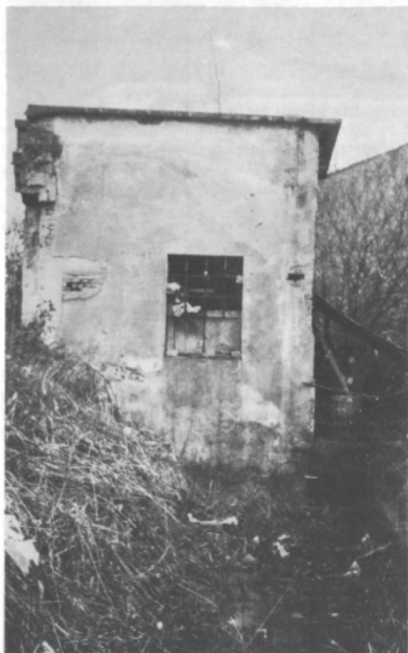
Sl. 13. V začetku 20. stoletja so bili ob Rižani še številni mlini in drugi obrati na vodni pogon. Večina mlinov je propadla, obenem pa propadajo tudi mlinščice, ki so vršile pomembno vlogo ob visokih vodah
