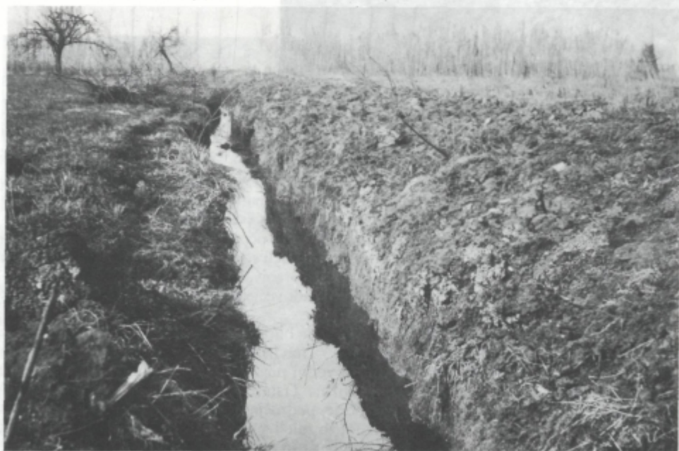
Sl. 12 Dolina Badaševice je bila meliorirana tudi v srednjem delu. Poleg glavnih vodnih kanalov so tudi manjši, ki odvajajo vodo s posameznih parcel. Ker je kmečkega prebivalstva vedno manj, vzdržujejo stalno le manjše število lokalnih kanalov
