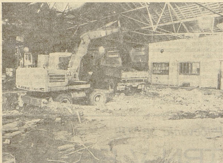
Še zadnje ostanke plamenične peči natovarjajo, nato pa bodo nadaljevali z izkopom temeljev za novo peč
