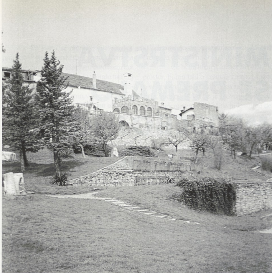
Ferrarijeve hiše – pogled z juga, s sprehajalne poti izpod Stolpa na vratih proti Koblilju.
