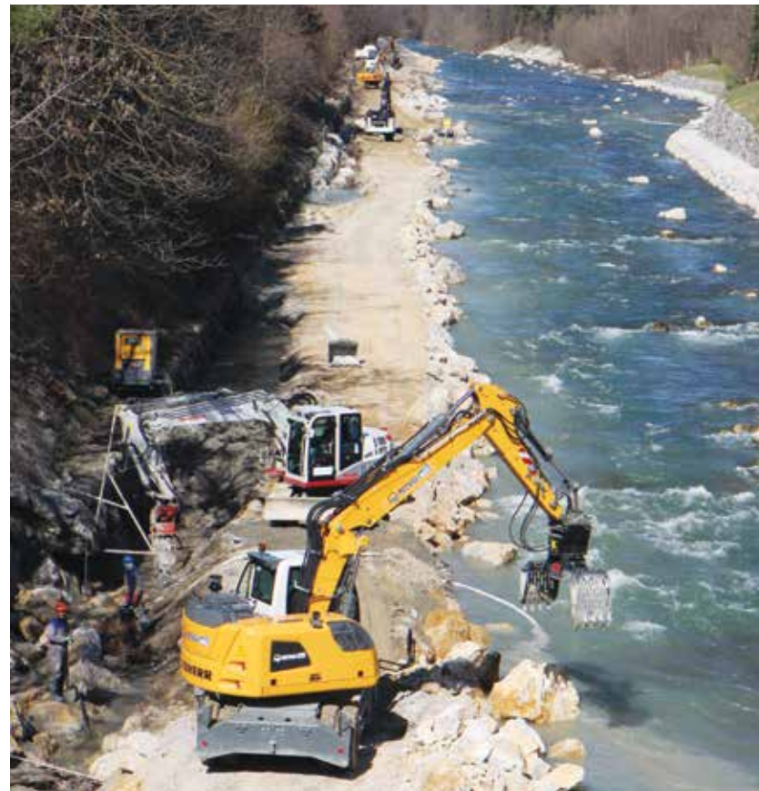
Sanacija desnega brega Savinje
