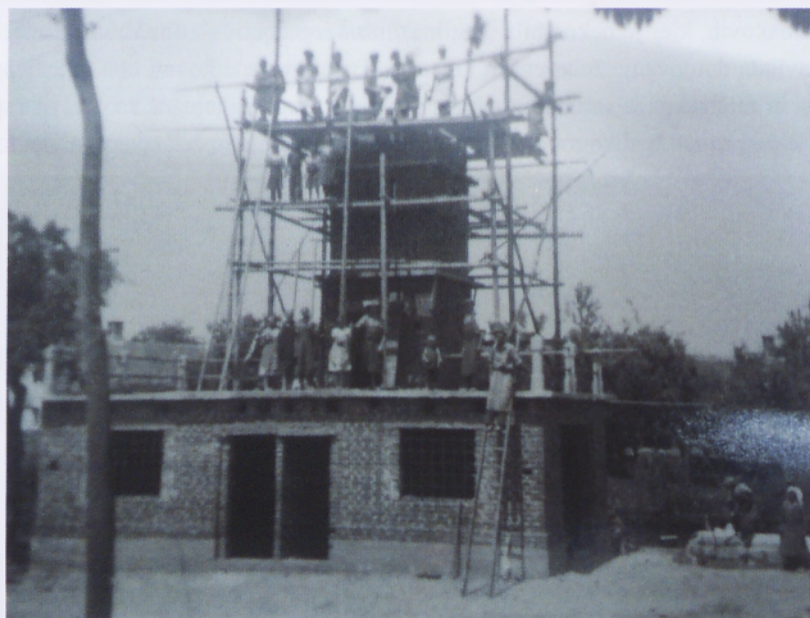
Slika 6: Gradnja gasilskega doma na Spodnjem Krapju.
