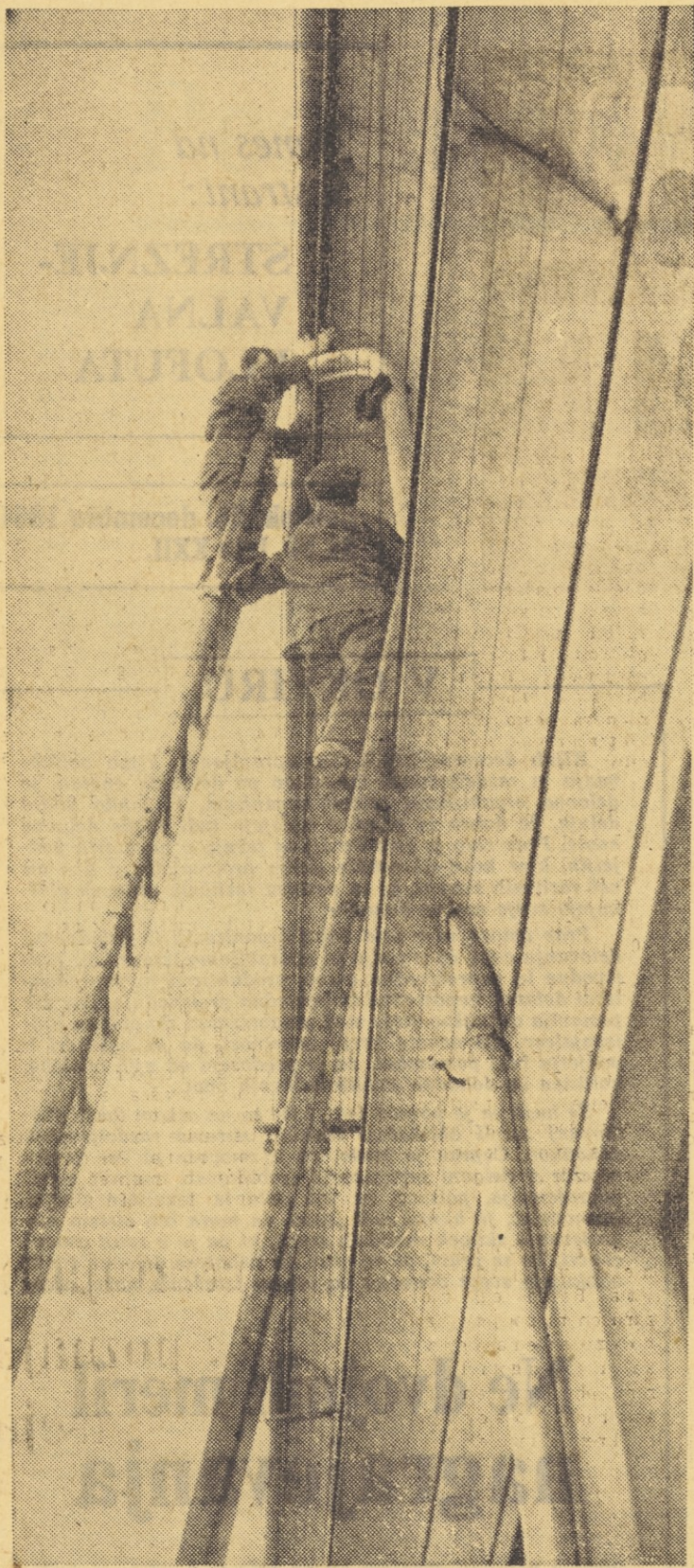
Poledeneli pločniki so še posebno nevarni za kleparje, ki često nezavarovani na visokih lestvah popravljajo žlebove. Ponavadi se tega zavedejo šele takrat, ko je žal prepozno. Foto M. Sparovec
