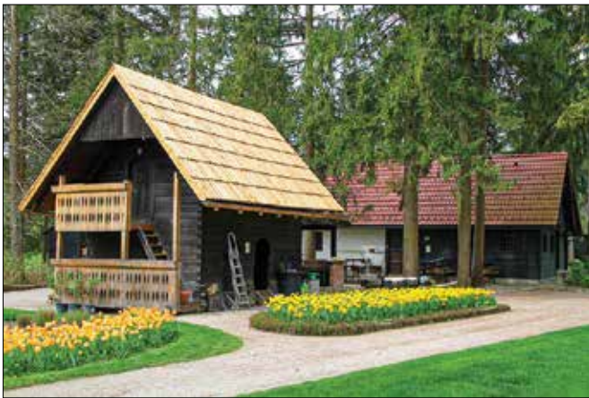
Kašča ob kmečki hiši je dobila novo streho iz skodel.
