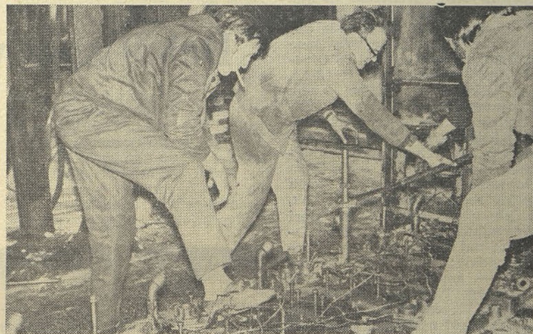
Remont strojev na 40-tonski peči v TOZD II
