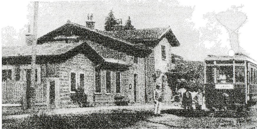
Tramvaj za Piran pred (nekdanjo) železniško postajo v Luciji.
