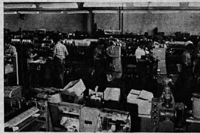
Vedno zahtevnejša proizvodnja ...
