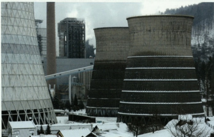
Hladilni stolpi, ki so dominirali na prostoru novega bloka 6, bodo padli že v letu 2010. / Foto: Jože Miklavc
