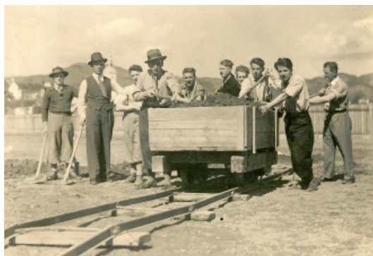
Priložnostni tiri z vagončki za prevoz zemlje in kamenja pri gradnji nogometnega igrišča v Puštalu (po letu 1936).
