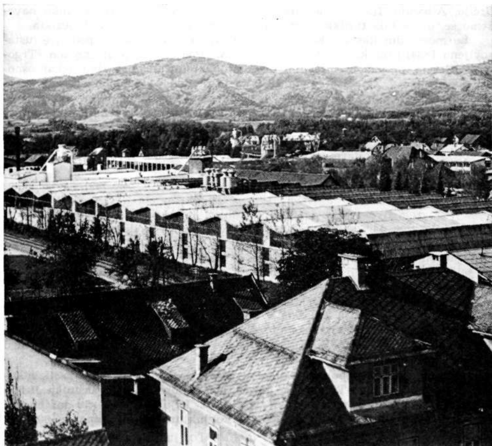
Centralni obrat Lesne industrije »Jelovica« na Trati. V ozadju obrat Gradis, v ospredju hiša bivšega lesnega trgovca Josipa Vebra. (Foto Kališnik)
