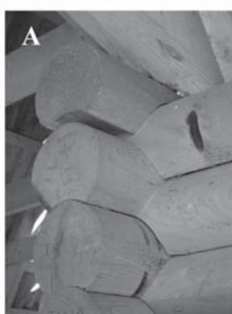
□ Slika 1. Vnaprej izdelani elementi se sestavijo v konstrukcijo na mestu gradnje, A- tradicionalna gradnja iz brun (lastni arhiv), B- konstrukcija iz lesenih zidakov (www.steko.de), C- skeletna konstrukcija, linijski elementi (Grütmacher, 1998)
