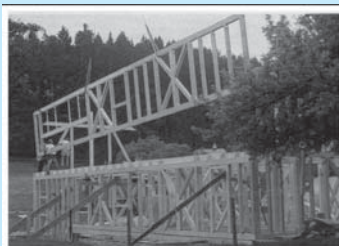
□ Slika 2. Montaža etažnega povezja (Dietrich Fink, 1997). Montaža večetažnih skeletnih povezij: A- montaža delnih večetažnih povezij, B – montaža celotnih povezij (Boršič, Bezenšek, 2004)
