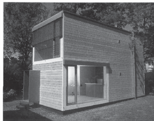
□ Slika 6. Modularna hiša z možnostjo naknadnega povečanja osnovne enote (prospektno gradivo podjetja WeberHaus GmbH & Co)
