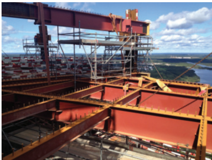
Slika 49 • Montaža nosilcev plošče.
