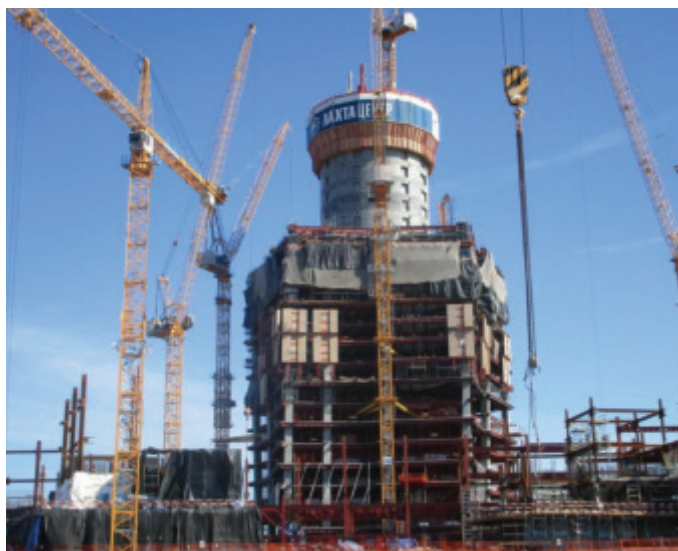
Slika 59 • Gradnja prvih etaž stolpnice.
