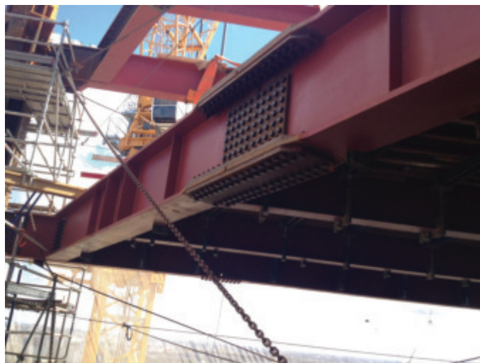
Slika 50 • Vijačeni stik nosilca plošče.
