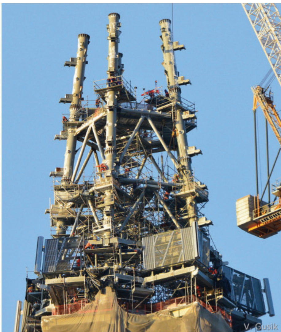
Slika 61 • Montaža konstrukcije koničastega vrha stolpnice (Foto: V. Gusik).
