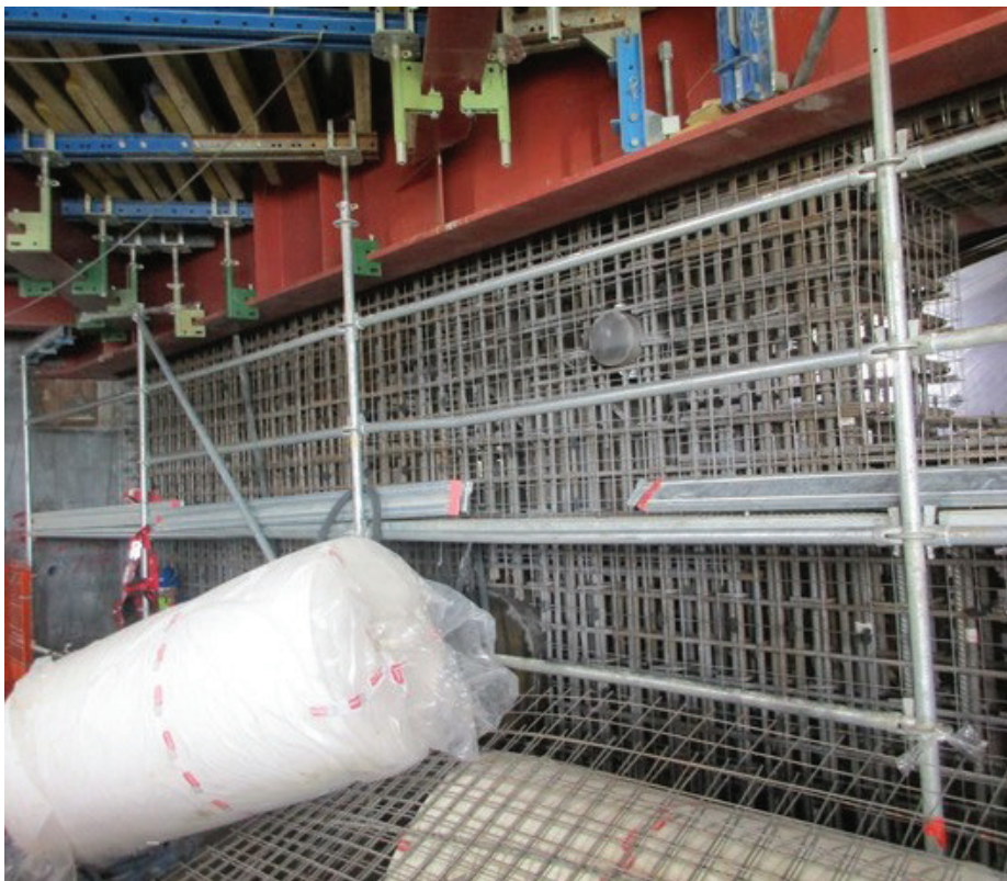
Slika 34 • Armatura stene prečnika v 33. etaži.
