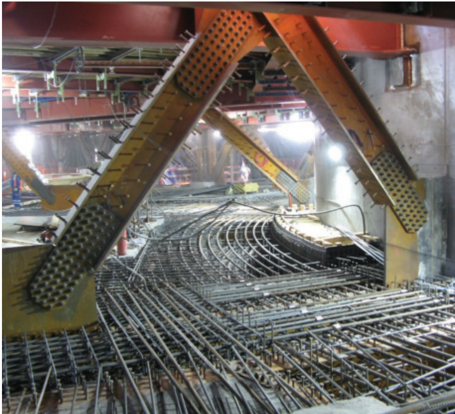
Slika 33 • Jekleno paličje ter armatura spodnje plošče in krožnega nosilca.
