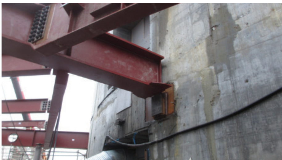
Slika 46 • Stik nosilca stropa s steno jedra.
