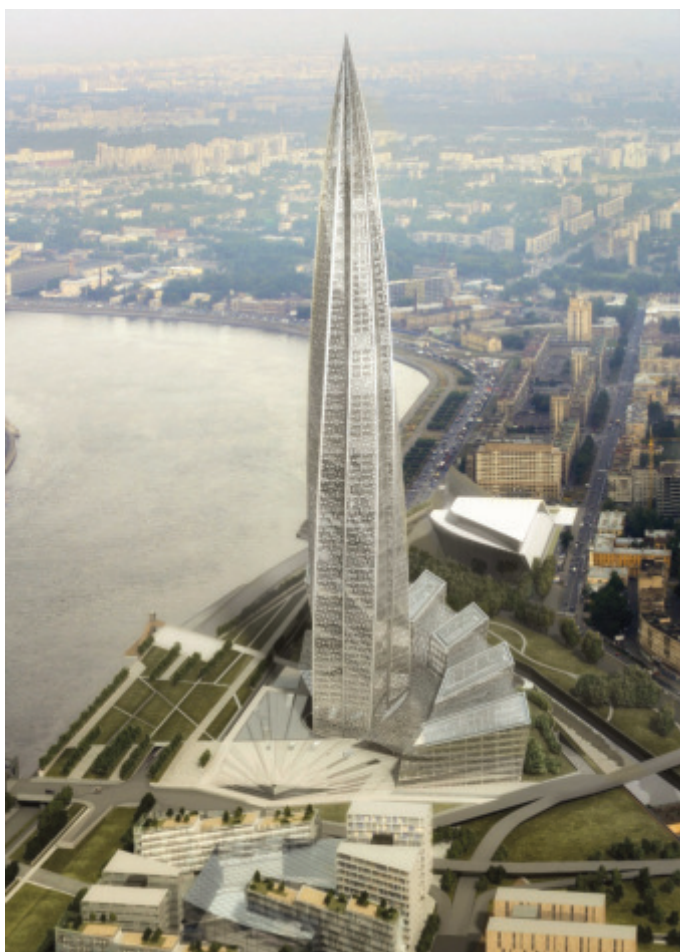
Slika 3 • Prikaz kompleksa Okhta Center.
