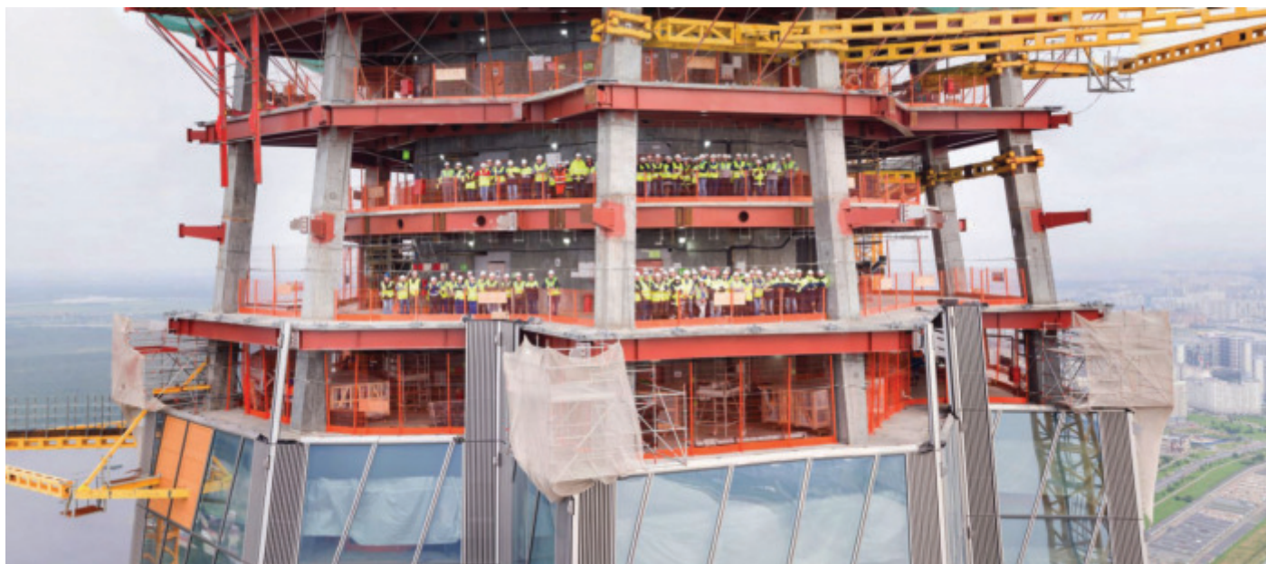
Slika 6 • Udeleženci projekta na gradbišču Lakhta Center.
