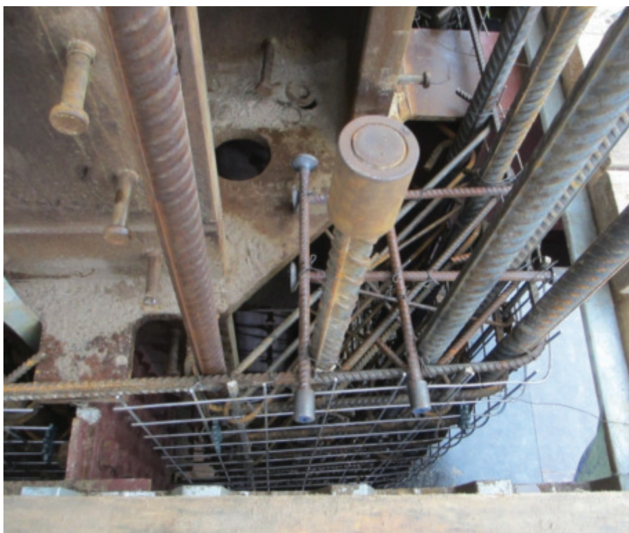
Slika 44 • Armatura stebra in sidra v vogalu stebra.
