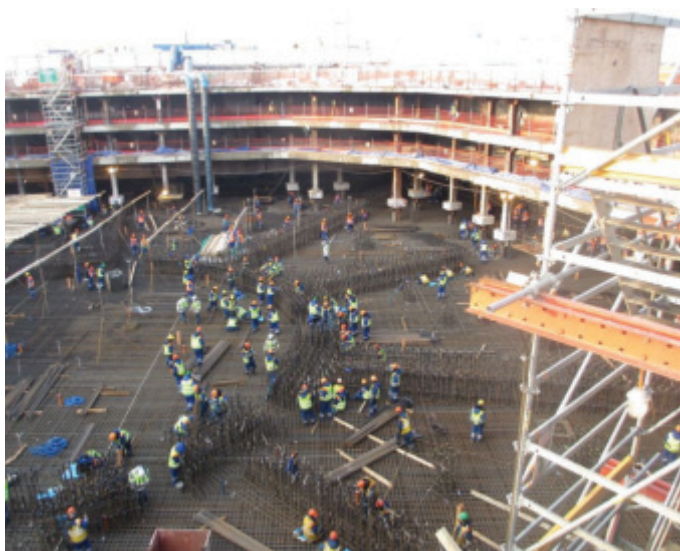
Slika 58 • Armiranje škatlastega temelja.
