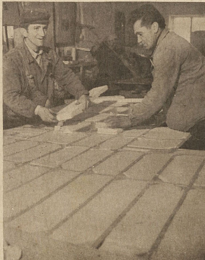
Isolacija poda je važna zaradi toplotne in akustične izolacije
