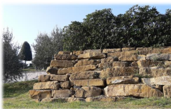
Slika 84: Suhozidna gradnja Vir: Lasten
