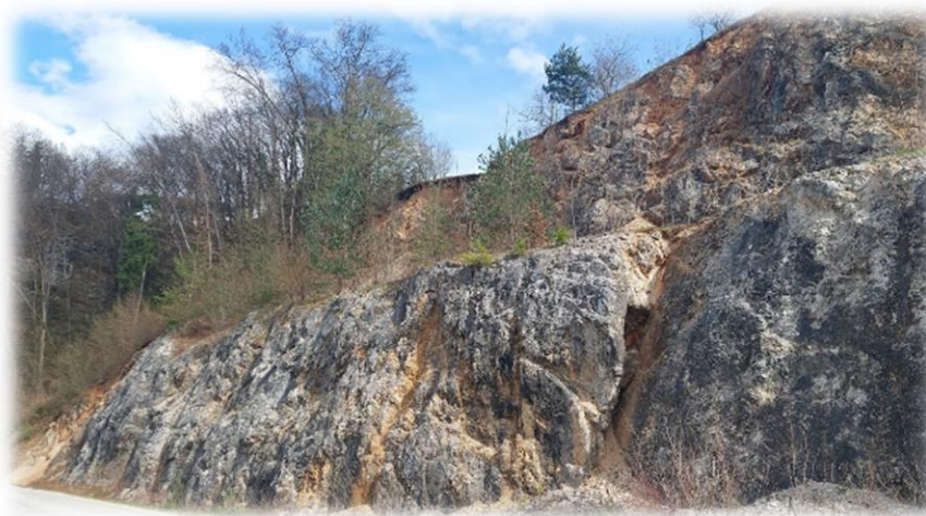
Slika 7: Sanacija območja pri Polici Vir: Lasten
