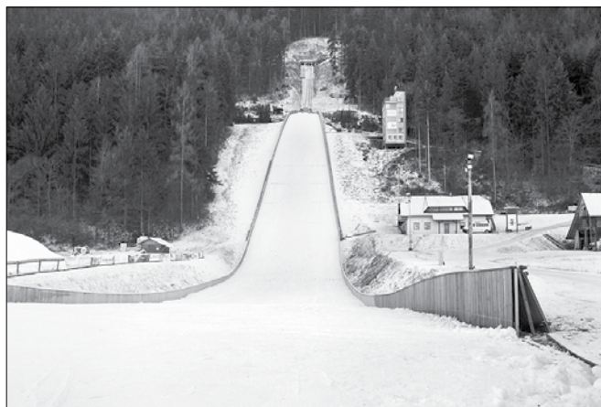
Obnovljena skakalnica na Ljubnem je pravi ponos Ljubencev in slovenskega smučarsko skakalnega športa. (Foto: Jože Miklavc)
