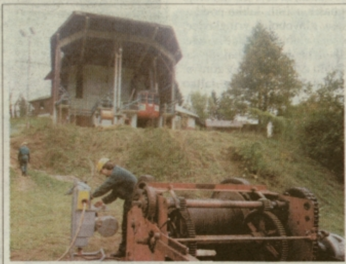
Delavci v jesenskih dneh hitijo z zamenjavo gondolskih vlečnih vrvi v Žekovcu.
