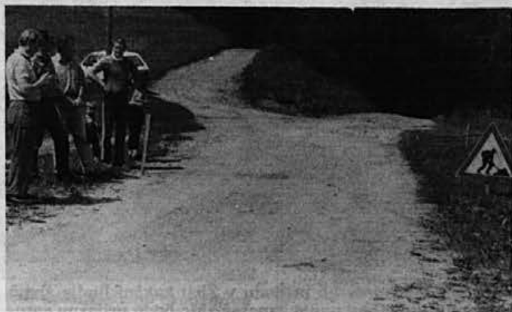
Od tu — pa vse do Žirov — bo tekla asfaltna trasa
