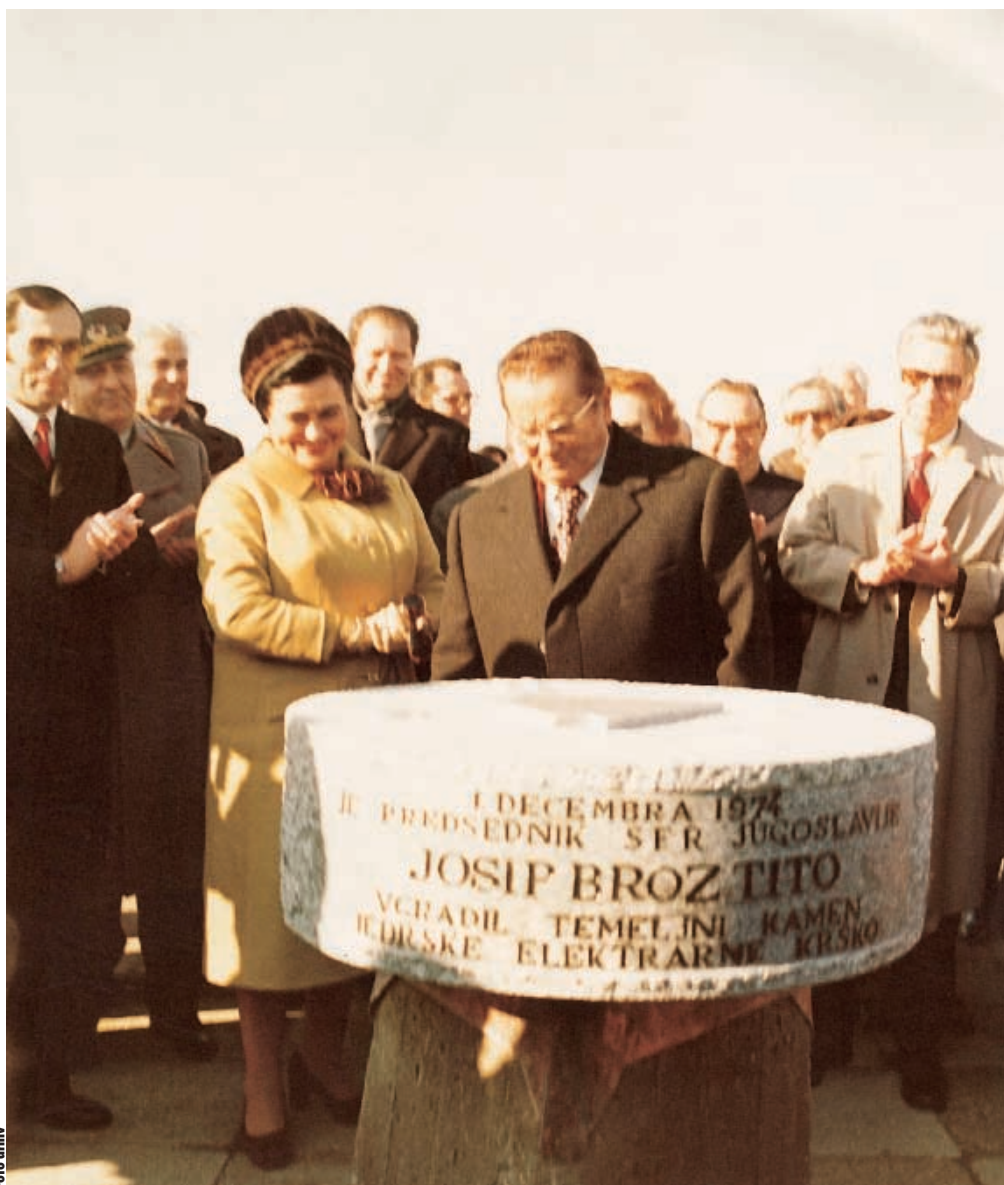
Tri mesece po položitvi temeljnega kamna so v Krškem začeli graditi elektrarno.
