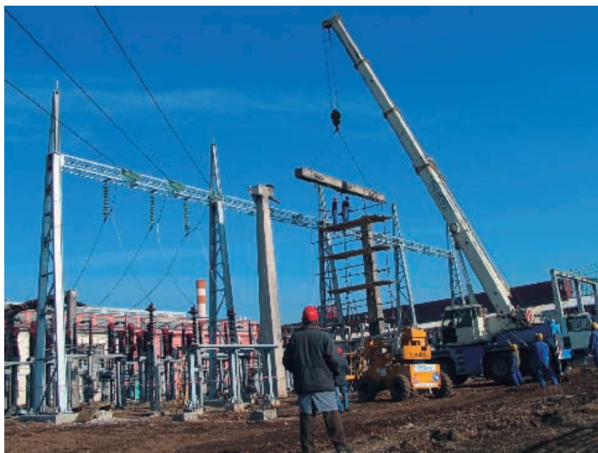
Zaradi omejenega prostora so morala biti vsa dela opravljena s skoraj milimetersko natančnostjo.
