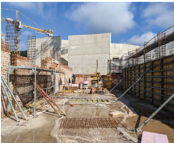
Slika 5. Opaži za ojačitev sten objekta A (spomeniško zaščiten objekt), junij 2023.
