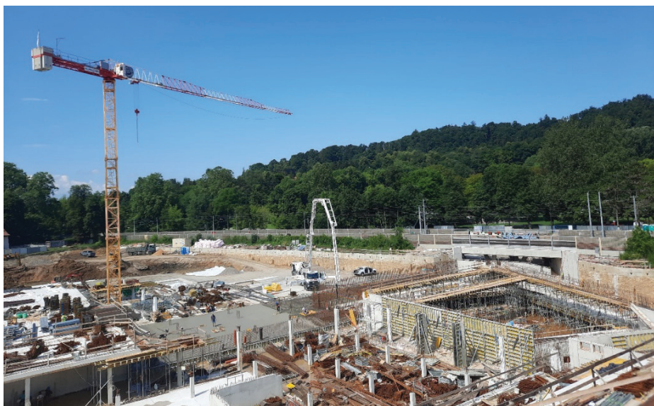
Slika 15. Stene ogrevalnega bazena in v ozadju betonaža tretjega takta garaže, junij 2023.
