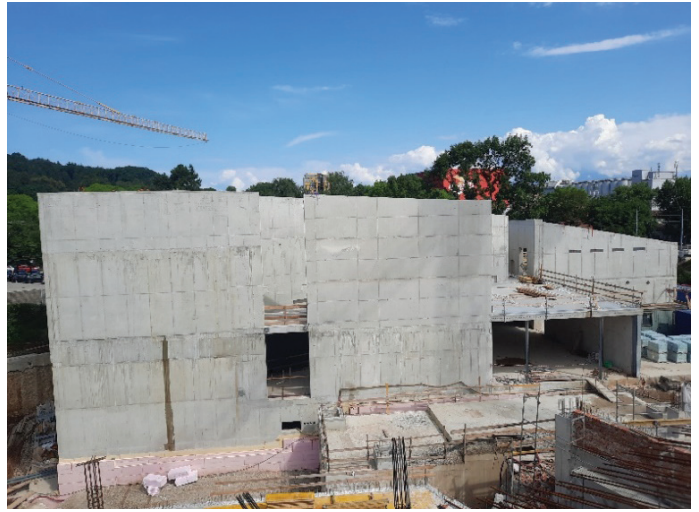
Slika 11. Dokončani vidni betoni objekta C, julij 2023.
