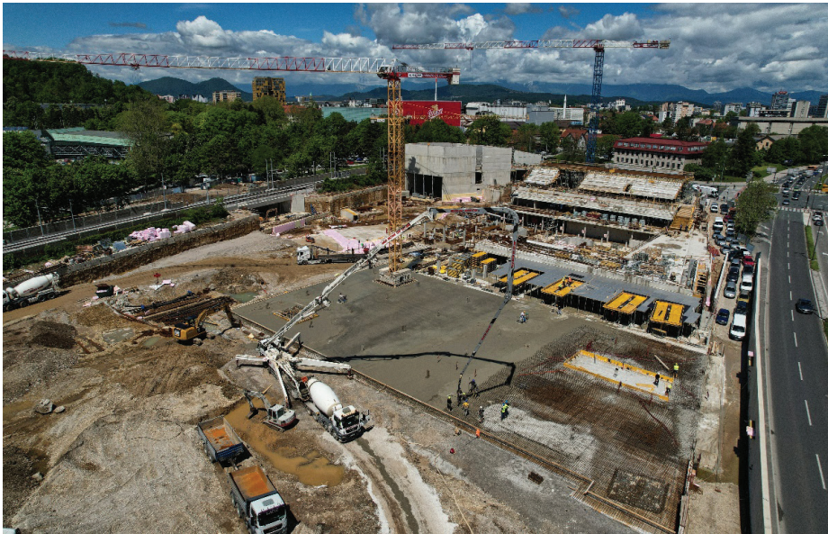
Slika 12. Betonaža drugega trakta talne plošče garaže – 1200 m 3 , maj 2023.
