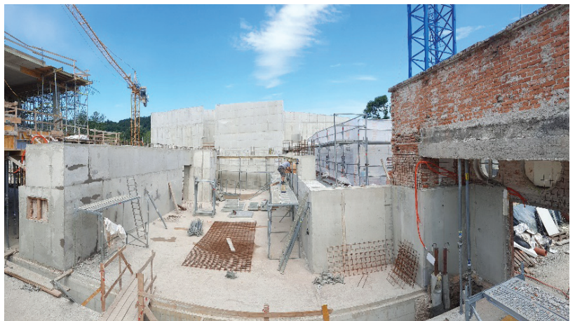
Slika 6. Statično ojačane stene objekta A, v katerega bo umeščena recepcija z Bloudkovo spominsko sobo, julij 2023.
