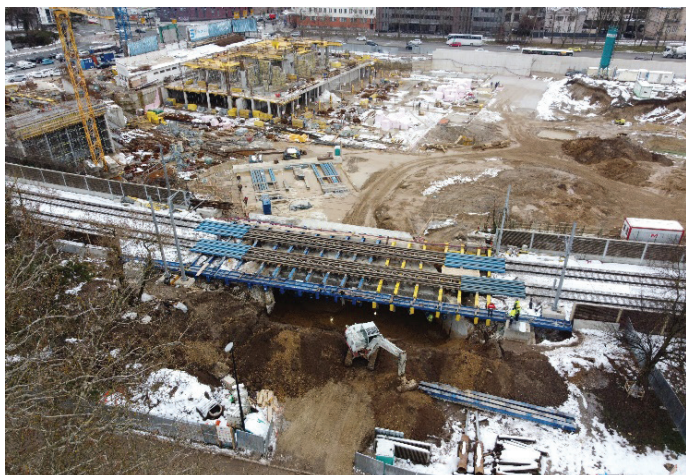
Slika 13. Izgradnja Lattermanovega podhoda v fazi podiranja, februar 2023.
