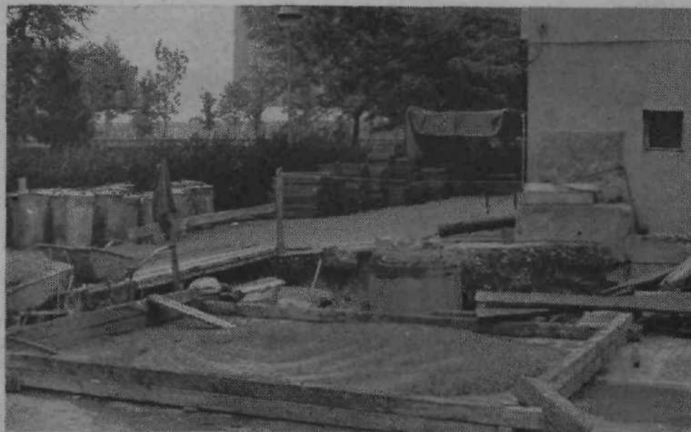
V Savskem naselju letos v 6 blokih napeljujejo daljinsko ogrevanje. Stanovanjska skupnost je zagotovila sredstva, izvajalci pa bodo zaključili dela v pogodbenem roku. Tako bodo dela predvidoma končana v blokih Matjaževa 1-5, Luize Pesjakove 13-19, Fablanjeva 17-23 in 31-35 do srede oktobra meseca. Nekaj kasneje so začeli z delom v blokih Majaronova 2-6 in Fablanjeva 2-15, kjer bo centralna kurjava začela greti predvidoma sredi novembra. Vsa zunanja dela potekajo po planu in bodo zaključena do srede oktobra, tako da bo centralna kurjava kljub vsem težavam kmalu nared.
