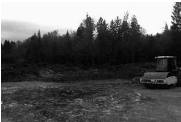
Utrjevanje terena za gradnjo
