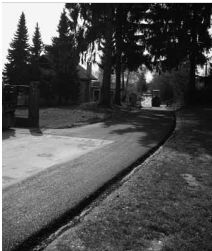
Končana so dela pri obnovi vodovoda v Zapotoku proti šoli.
