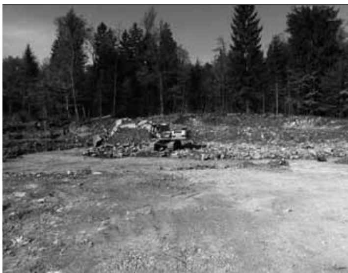
Pripravljalna dela za gradnjo novega centralnega vrtca Ig
