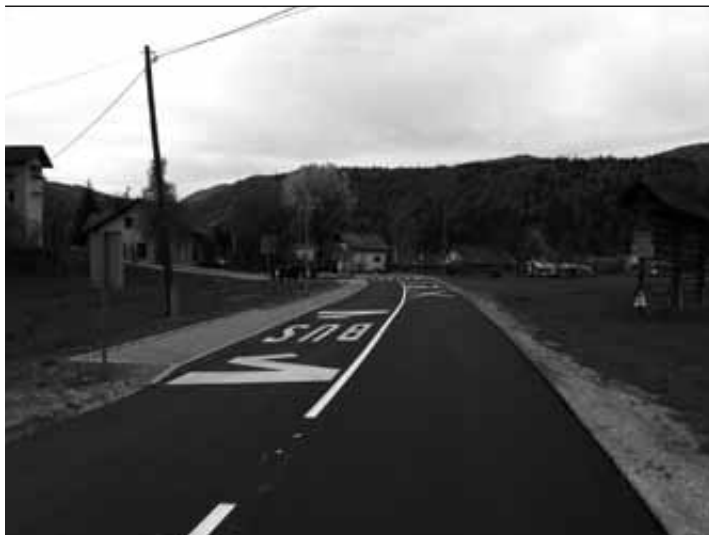
Preplastitev ceste v lški vasi na območju gradnje pločnika
