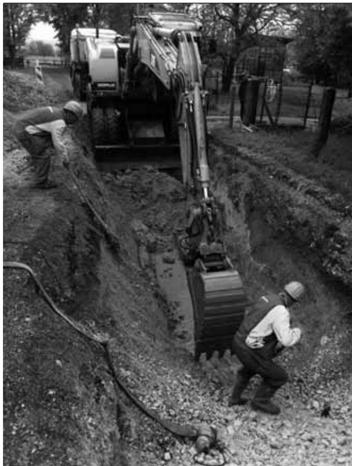
Gradnjo komunalne infrastrukture v lški Loki otežuje visoka podtalnica.
