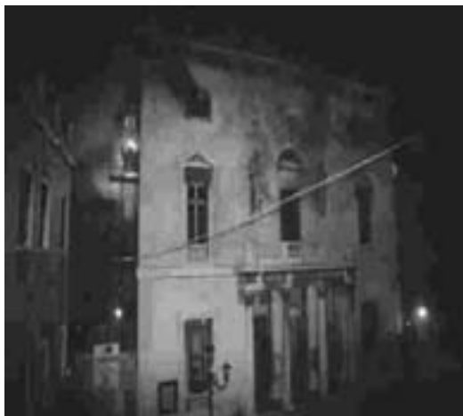
Požar gledališča Fenice (Benetke) je leta 1996 popolnoma uničil stavbo
