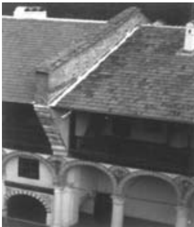
Po silovitem požaru leta 1833 so Rilski samostan (Bolgarija) pregradili s požarnimi stenami
